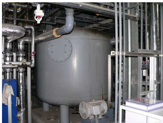
⑥ ろ過器(プールの水の汚れを取り除きます)
